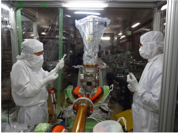
**Fig. 23** NEG コーティングダクトの設置
