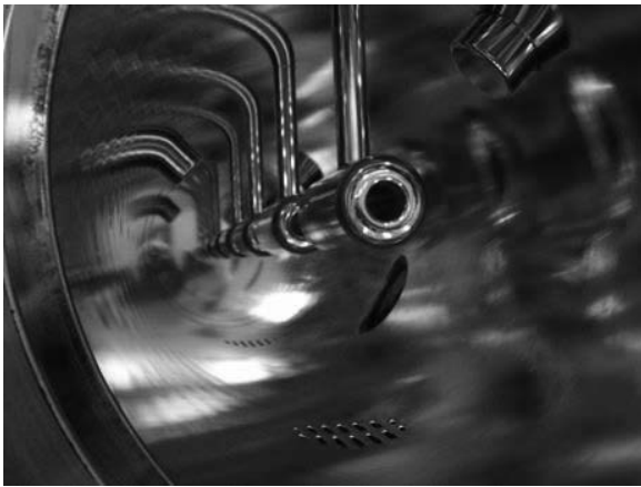
Fig. 16 J-PARC SDTL 内部
