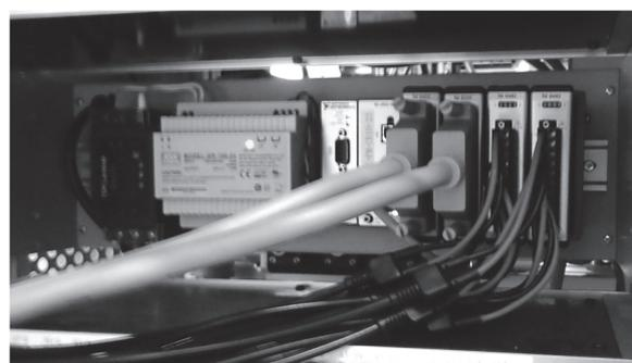
Fig. 20 compactRIO を用いたインターロックシステムの外観。
