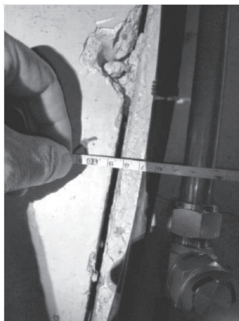
Fig. 2.2 : ミリ単位で開いたエキスパンションジョイント。
