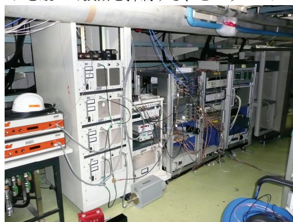
図 2-78 横方向 FB の為の RF アンプ
