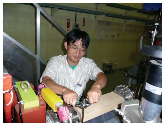
図 2-68 配管作業の様子
