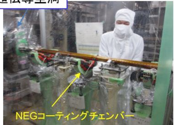
Fig. 122 cERL 主空洞クライオモジュール前後のNEGコーティングチェンバー接続の様子。
