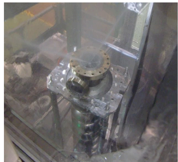
Fig. 50 高圧超純水洗浄(HPR)の様子
