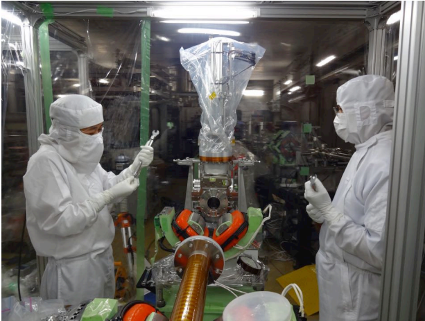
Fig. 23 NEG コーティングダクトの設置
