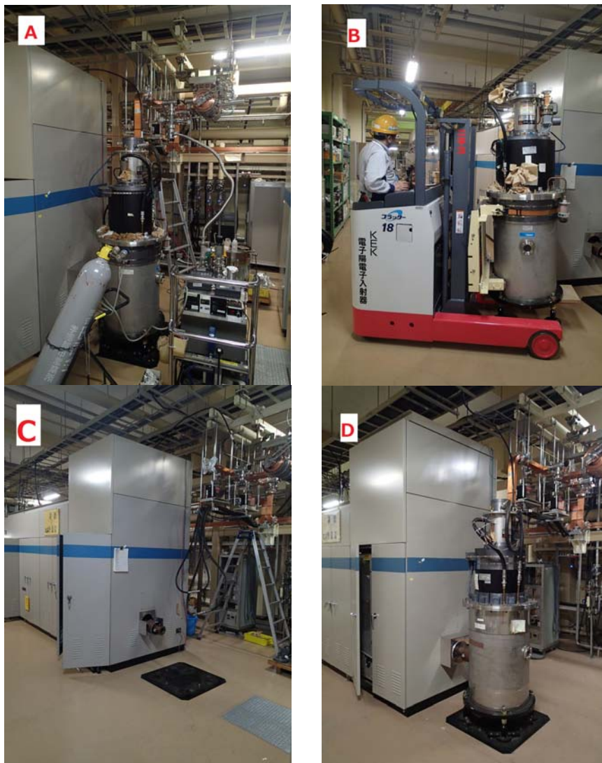
図 2 6 クライストロンアセンブリの交換のようす
