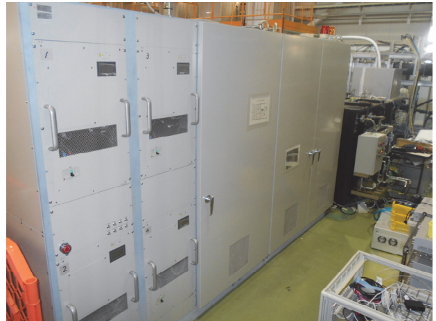
Fig. 33 KEK STF のバウンサー型電源の写真
