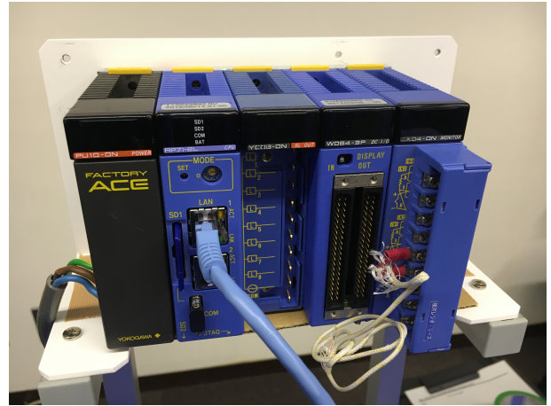
図 15: F3RP71 を用いたシステムの外観。左から順に電源モジュール、F3RP71、3 台の I/O モジュールが実装されている。
