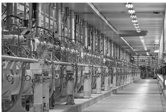
Fig. 36 入射器棟に並ぶ加速管。
