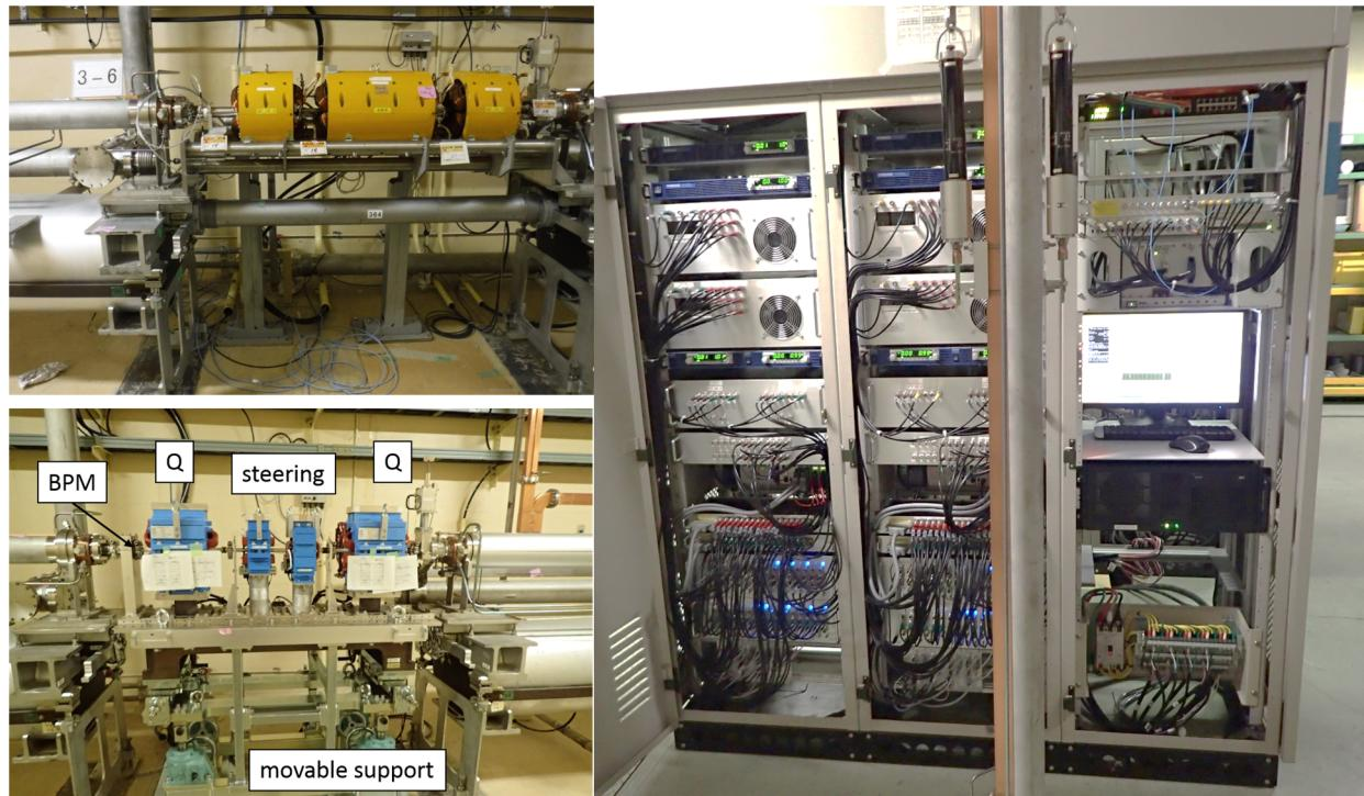
Fig. 9 置き換え前の DC マグネット(左上)、置き換え後のパルスマグネット(左下)、電源及び制御系(右)。
