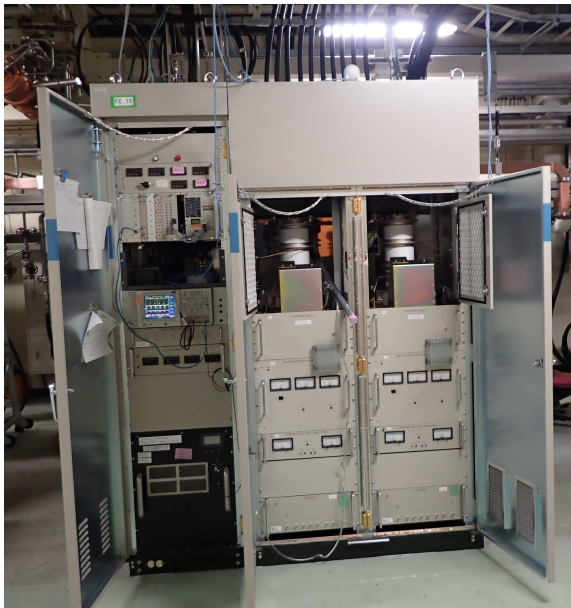
Fig. 33 FC 用パルス電源の外観。
