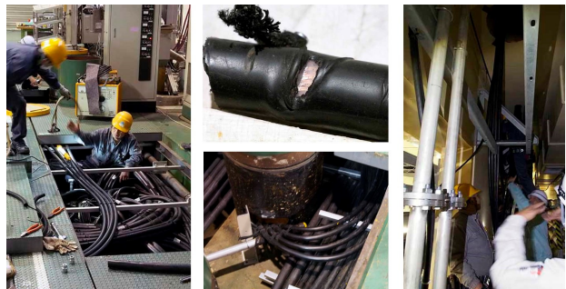
Fig.27. QLA2LE ケーブル地絡箇所調査の様子
