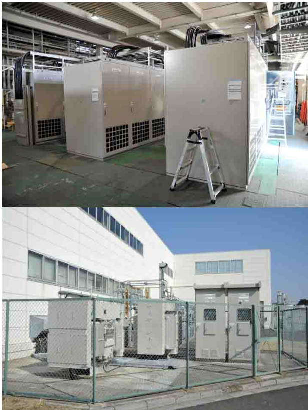
Fig. 21. D5 電源棟に設置したウィグラー電磁石大型電源と屋外機器
