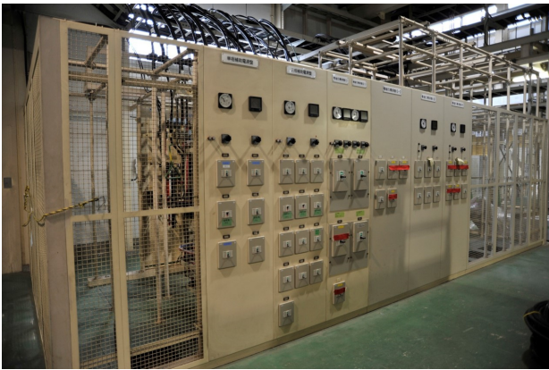
Fig. 26. D11 電源棟受電設備の分電盤。8つの各電源棟で 279 個の遮断機を更新した。
