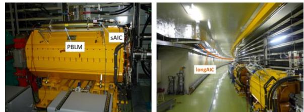
Fig. 3-14 PBLM、AIC の設置状況
