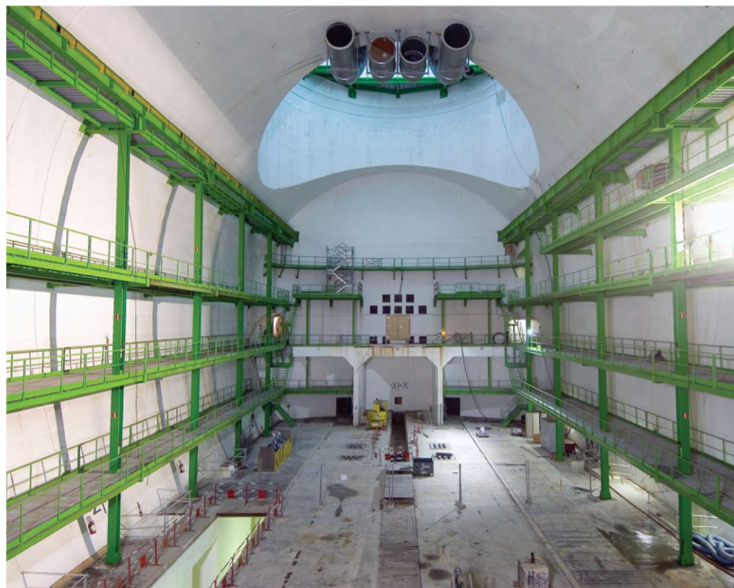
検出器ホール 地下100m、幅 27 m, 高さ 25 m, 長さ 53 m
