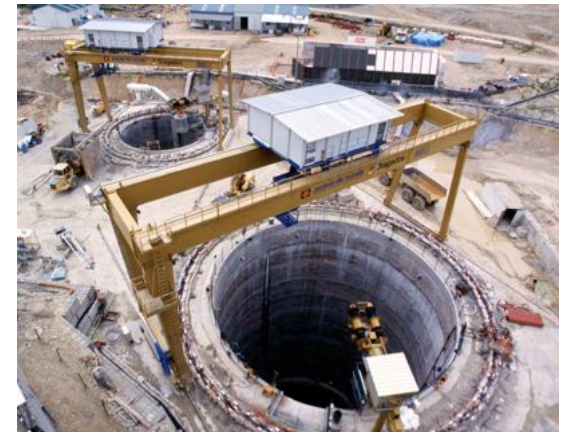
(例) CERN LHC CMS立坑：直径20.5m&12m、深さ100m
