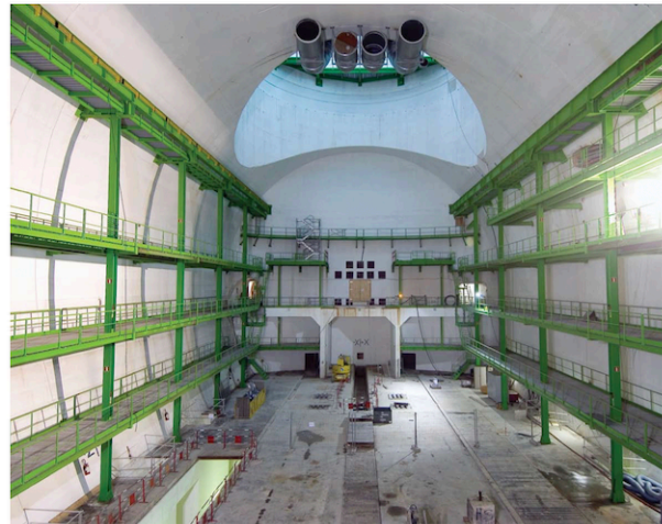
検出器ホール: 地下100m, 幅27m, 高さ25m, 長さ53m
