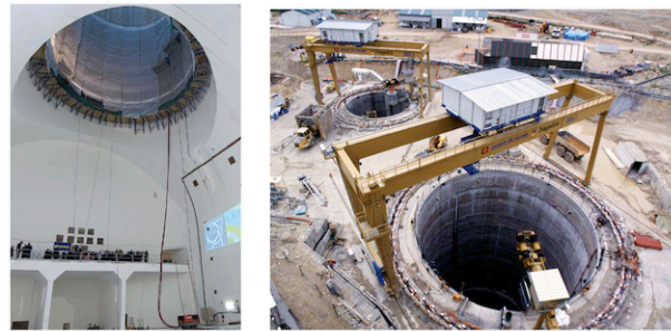
立坑：直径20.5m&12m、深さ100m
