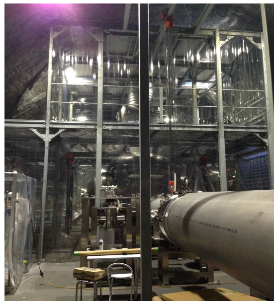
Fig. 24 総合組立を完了した Y-end 鏡室 (Fig.2) の低温設備
