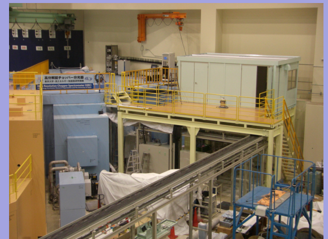
ビームダンプ・キャビン・デッキ
