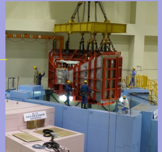
分光器遮蔽体・真空散乱槽
