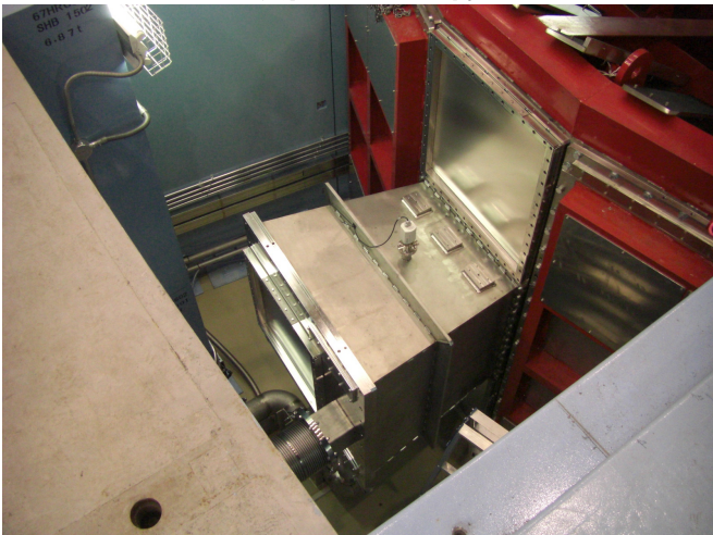
設置された様子
