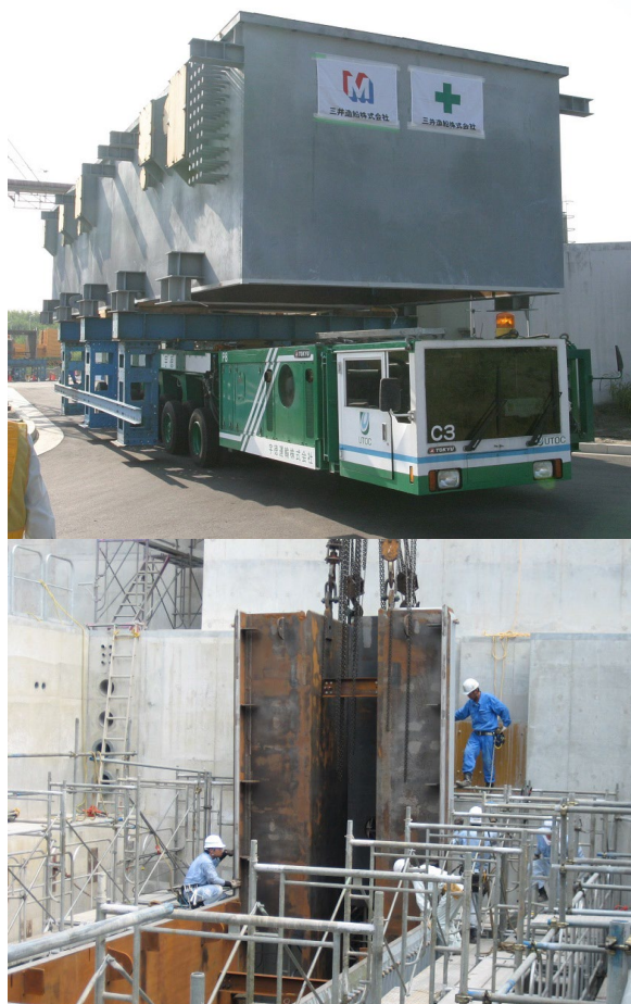
Fig. 8 ヘリウム容器ブロックの搬入と据付
