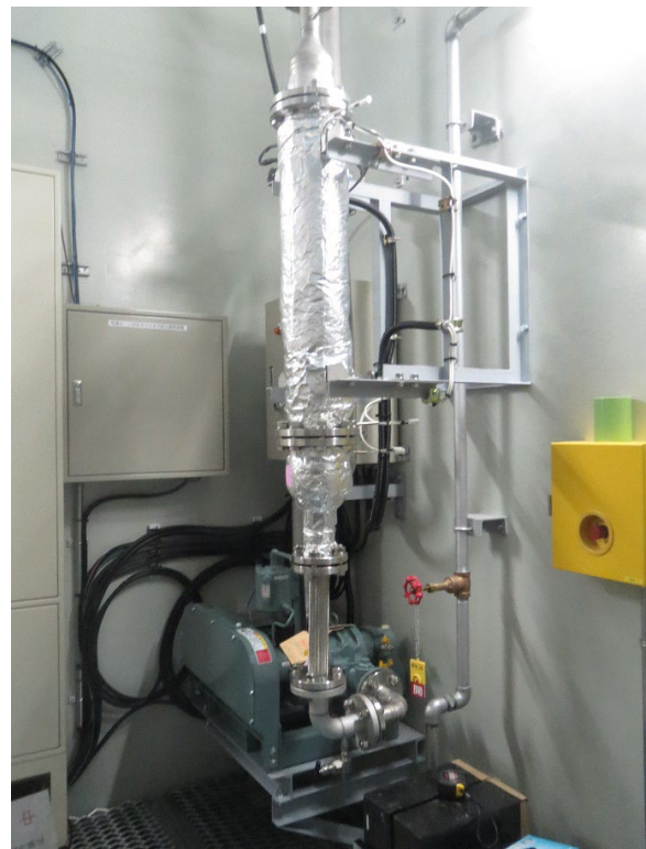
Fig. 22 水素再結合器
