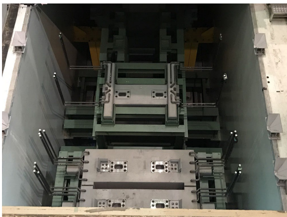
Fig. 11 鉄遮蔽体仮置架台
