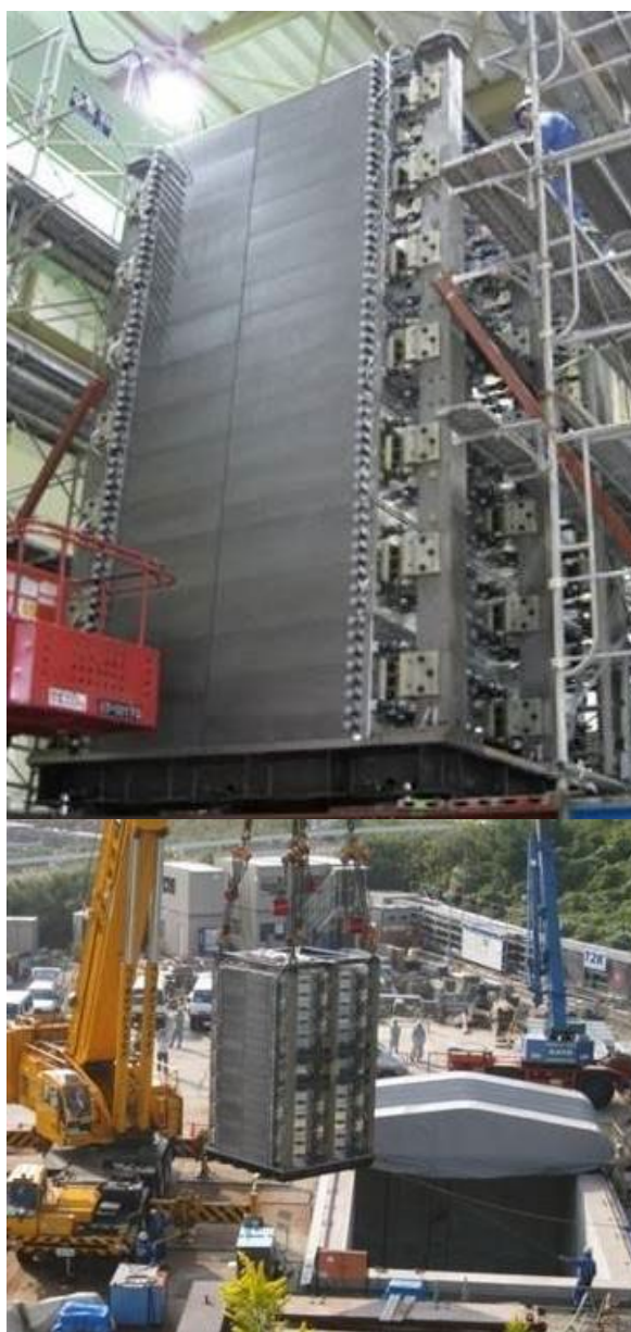
Fig. 18 完成したビームダンプコアと設置
