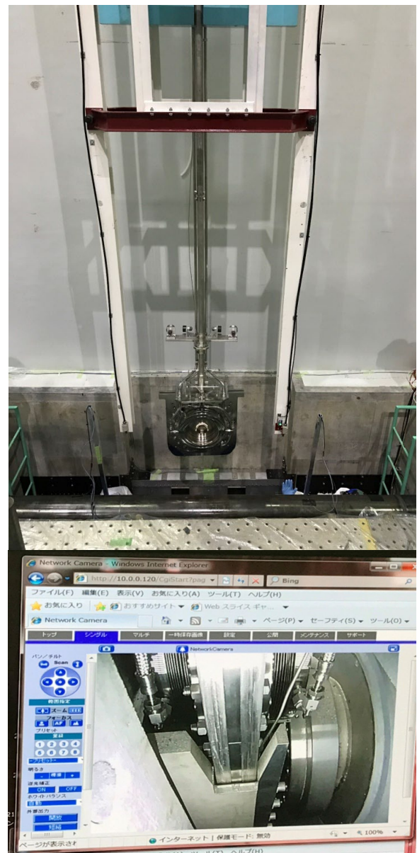
Fig. 34 新品のビーム窓設置の様子
