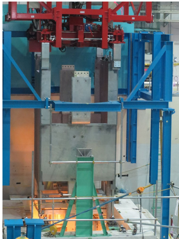
Fig. 28 メンテナンスエリアへの電磁ホーン の設置
