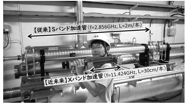
図 13 KEK 電子陽電子入射器の地下トンネル内にて撮影。S バンド加速管は、実際に加速器の運転で使用しているもの。その前で著者が担いでいるのは、CLIC 用 X バンド加速管。どちらも 1 本で 40 MeV (定格) 加速する。
