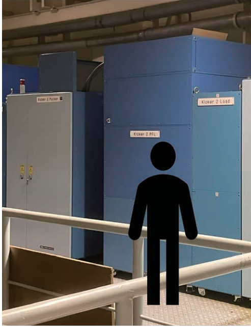
図 6: PF 伝送線型キッカー電磁石電源の一部
