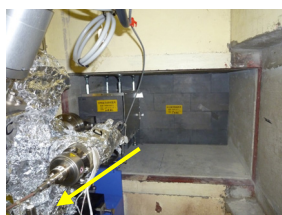
1. 貫通孔出口 (ホール側)
