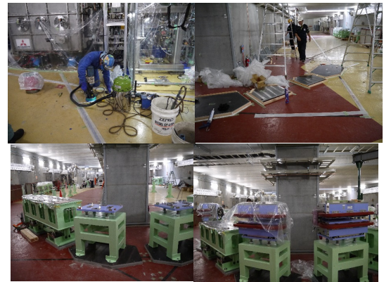
Fig. 10.34 cERL の電磁石設置の流れ (床にアンカーを打ち (左上)、ベースプレートを設置 (右上)、架台を設置 (左下)、電磁石を設置 (右下) という手順である。)
